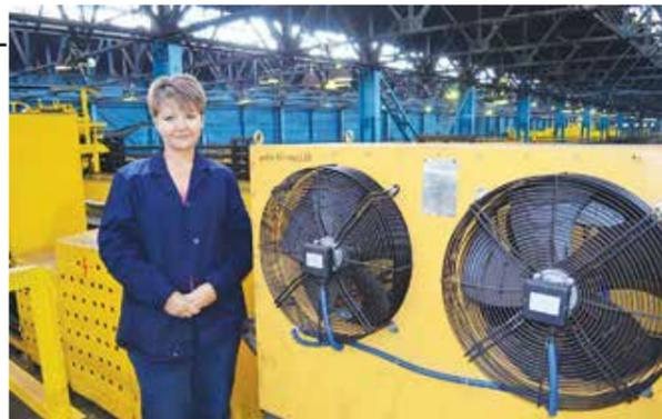
На мостовой кран машиниста 4 разряда Маргариты Елесиной (бригада № 540 ЦПриЭНТК кузнечного завода) новый кондиционер был установлен одним из первых. Воздуховод от него идёт в кабину, там же находится пульт управления, с помощью которого Маргарита Николаевна задаёт нужную температуру. Кран обслуживает цех рубки металла в корпусе № 4
